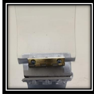
Gambar 4. 57 Pemasangan Cover Akrilik (Sumber : Dokumentasi Pribadi)
